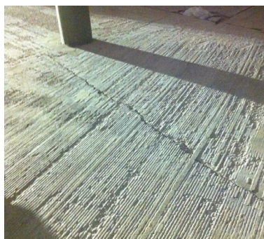
Oberflächenbild nach Fräsarbeiten
