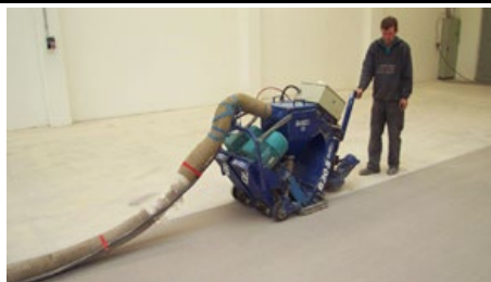
Kugelstrahlmaschine im Einsatz
