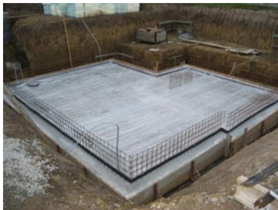
Frische Betondecke am Bau
