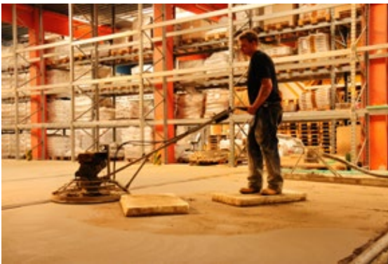
Glätten eines Schnell-Estrichs
